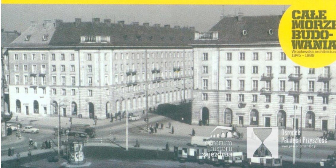
Budowa Kościuszkowskiej Dzielnicy Mieszkaniowej.
