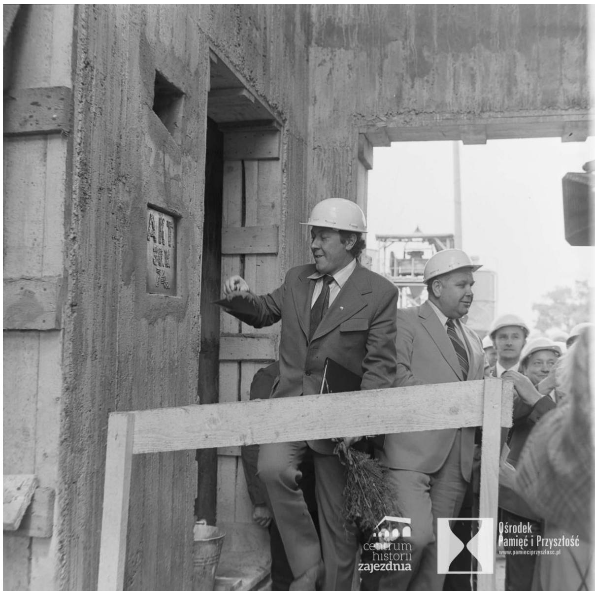
Uroczystość wmurowania aktu erekcyjnego pod budowę wieżowca „Poltegor” przy ul. Powstańców Śląskich w czerwcu 1974 roku, Stanisław Kokurewicz; OPIP
